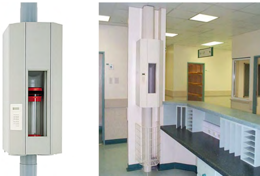
FIGURA 4.4 – Sistema de correio pneumático para hospitais
